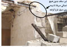
شکل ۹ - مواد تخریب ساختمانی ساخته شده با بلوک بتنی در شهر شنبه
