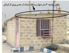
شکل ۱۴- طول کوتاه دیوارها و سقف سبک، علیرغم استفاده از نلالت شعیف گچ و خاک مانع از اسپیدیگن ساختمانی در مدرسه شهید خضر امیری در روستای باغان شده بود
