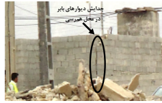
شکل ۵- نمود تخریب ساختمانی ساخته شده با بلوک بتنی در شهر شنه
